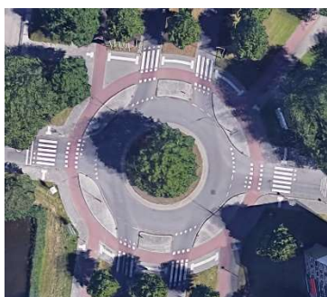
Fietspad rond rotonde
