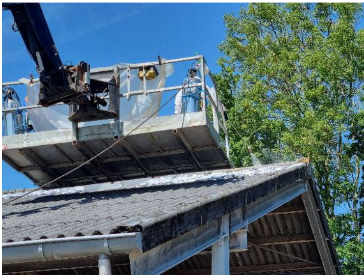
Foto 25: Inschuimen volgende deel asbestdak
