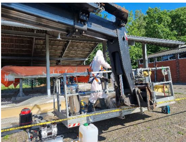
Foto 18: Inpakken verwijderde asbestcement golfplaten
