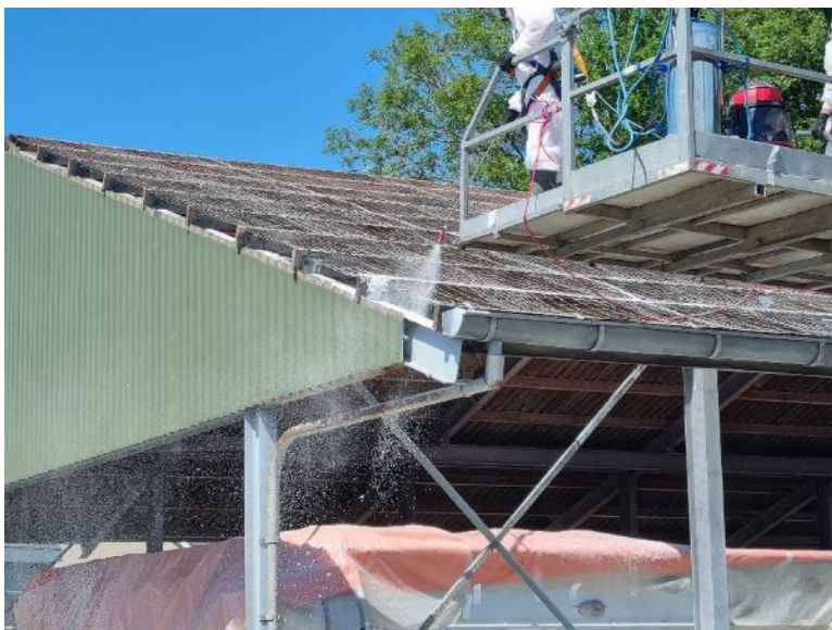
Foto 35: Inschuimen dakspanten.
