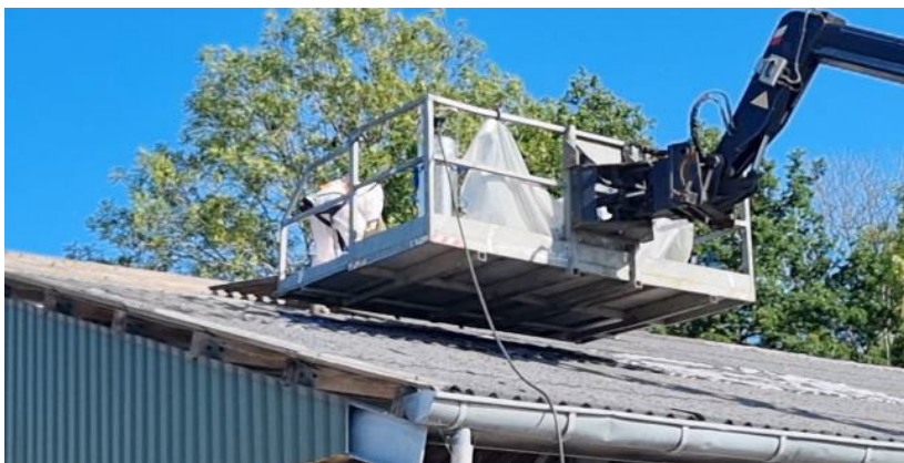
Foto 17: Verplaatsen (schuiven) asbestcement golfplaat naar bak verreiker
