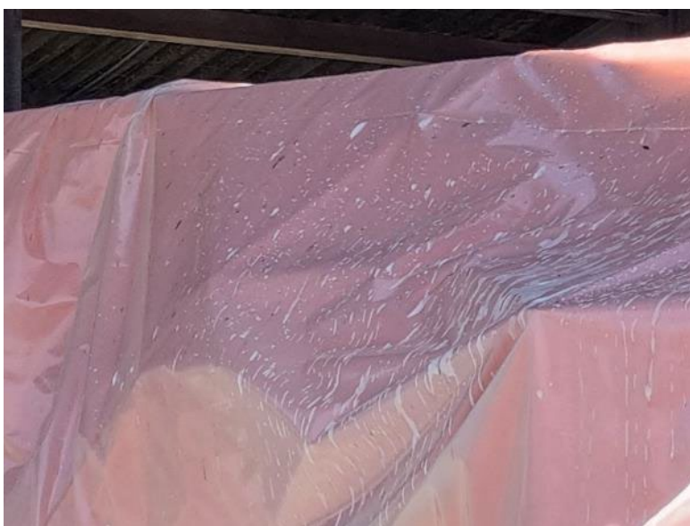
Foto 36: Zeil op objecten in de deurenloods onder asbestdak, schuim valt op het zeil tijdens inschuimen dakspanten (zie vorige foto's)
