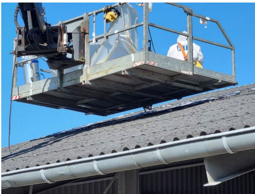
Foto 13: Losschroeven asbestcement golfplaat
