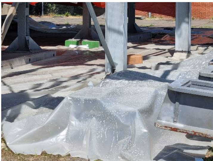
Foto 37: Zeil op objecten in/naast de deurenloods onder asbestdak, schuim valt op het zeil tijdens inschuimen dakspanten
