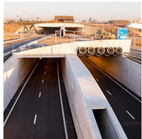
Figuur 9.1 Vier tunnelmonden
